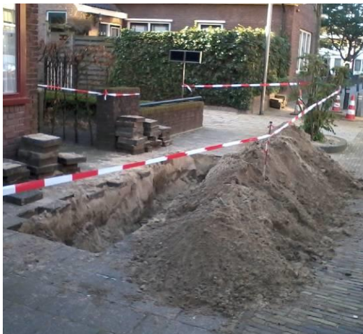
Onderhoud kabels en leidingen
